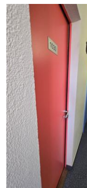
Portes d'entrée des logements – manque d'isolation acoustique
