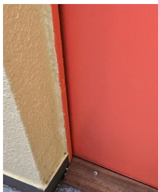
Portes d'entrée des logements – manque d'isolation acoustique
