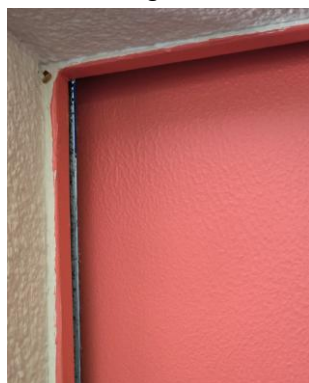
Portes d'entrée des logements – manque d'isolation acoustique
